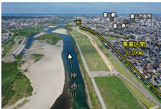
完成した堤防
