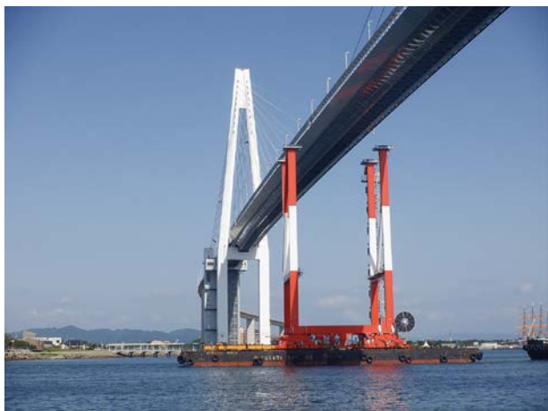
下部構の入港（海面から天端まで46.2m）
