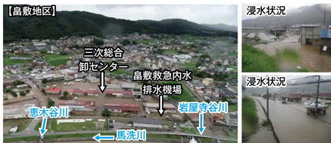
浸水被害状況（平成30年7月豪雨）
