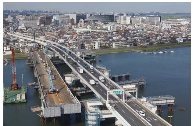
工事完成写真
