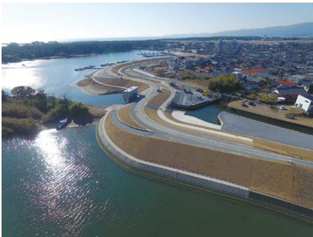
津波高潮堤防全景（上空より）
