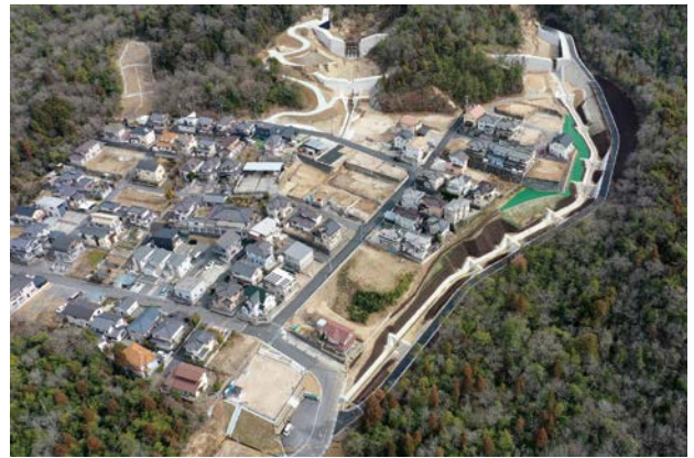
すべての工事が完了した川角地区
