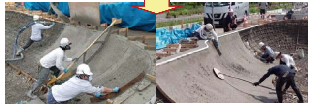
専門の職人による施工
