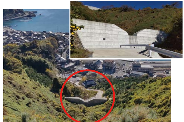
完成した砂防堰堤と保全集落
