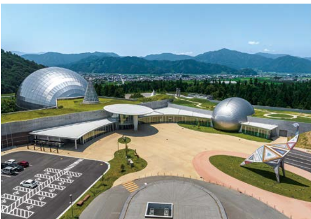
エントランス側から見た恐竜博物館
