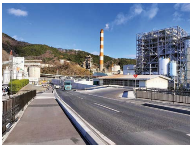
完成した防潮堤と隣接する工場
