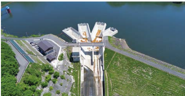
完成状況（令和6年5月撮影）
