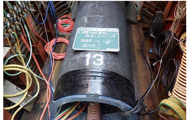
推進工法施工状況
