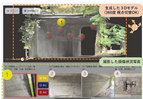
3Dモデルを活用した損傷写真の撮影箇所図イメージ
