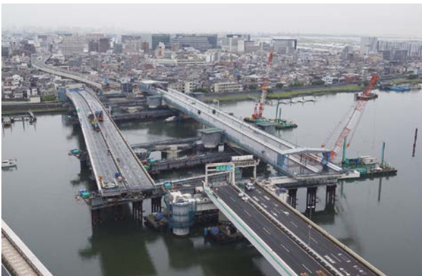
横取り一括架設（既設橋のスライド）
