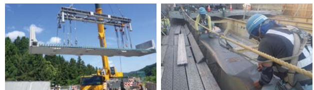
フルキャスト壁高欄の設置
