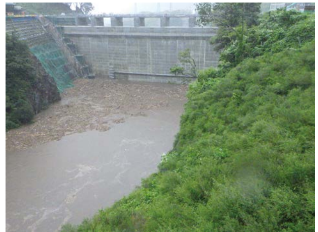
阿蘇立野ダムによる洪水調節（令和5年7月3日洪水）
