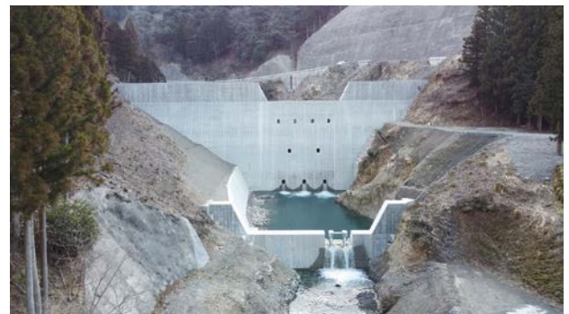
高地谷第1砂防堰堤
