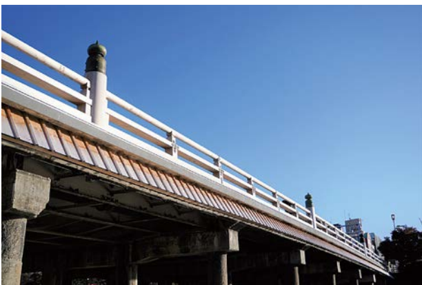
更新した木製高欄と桁隠し
