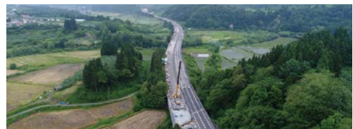
3橋連続施工現場状況写真
