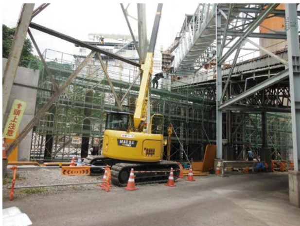
上空占有物件下での防潮堤施工
