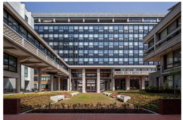
復活したサンクンガーデンからの本館南面外観
