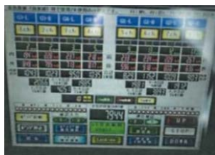
ジャッキ制御状況
