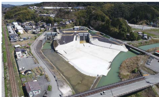
完成した新日下川放水路（呑口部）
