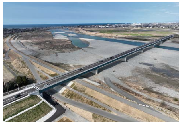
川北能美大橋（橋長L=537.3m）
